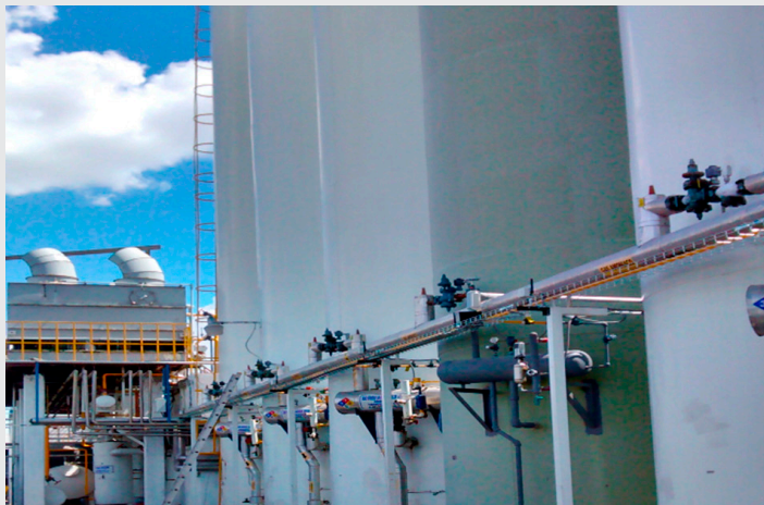
Figura 11. Silos con adaptadores instalados.
