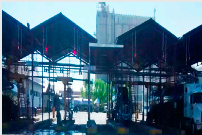
Figura 2. Carriles de descarga de pipas.
