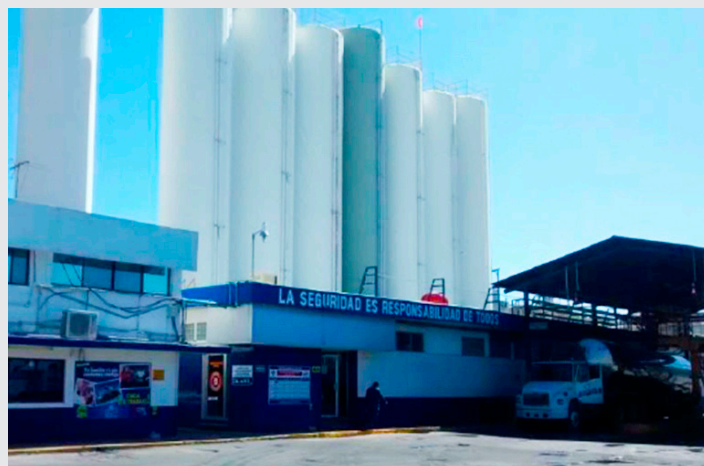
Figura 1. Silos de almacenamiento y enfriado de leche
